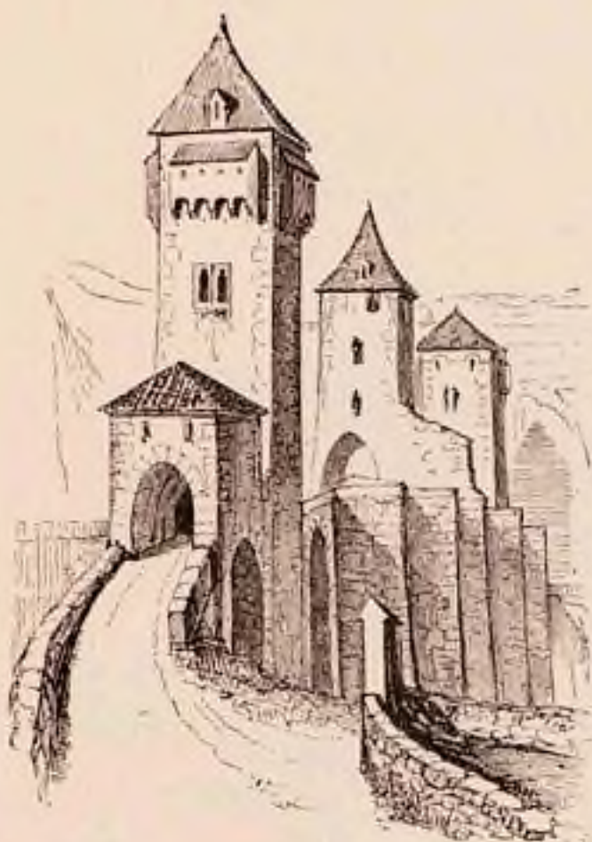
Fig. 20. — Pont fortifié de Valentré à Cahors (1308).
